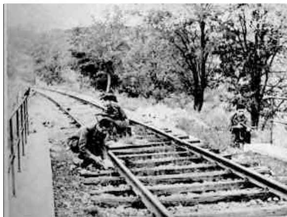
Des résistants sabotent une voie ferrée
